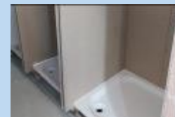
... Karim, Eduardo et Rachid travaillent à l'installation de cabines de douches.
